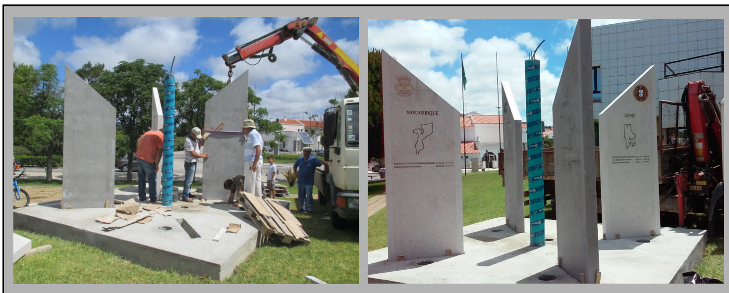
Imagens da construção do Monumento aos Combatentes junto ao Edifício dos Paços do Concelho
